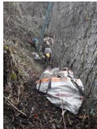
Conditionnement des blocs par hélicoptage
