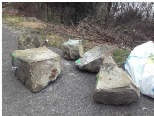
Blocs instables, évacués par hélicoptère
