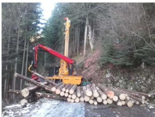
Installation de câblage sur la route Caux-Sonchaux
