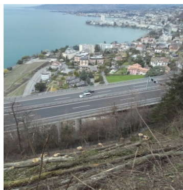
Sous Champbabau, bois préparés avant débardage par hélicoptère
