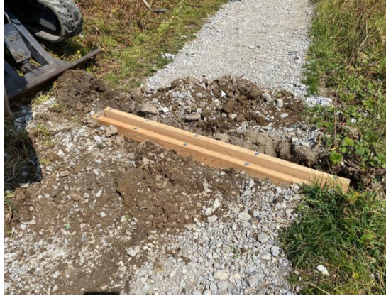
Renvoi d'eau sur le sentier du sommet des Rochers-de-Naye
