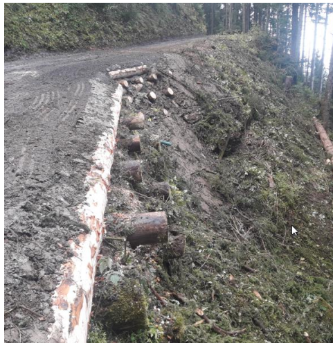
Caisson en bois route de Malajoux
