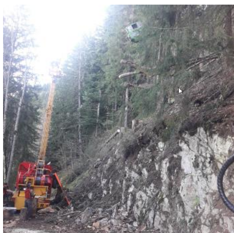
Câblage de bois sur la route Caux-Sonchaux
