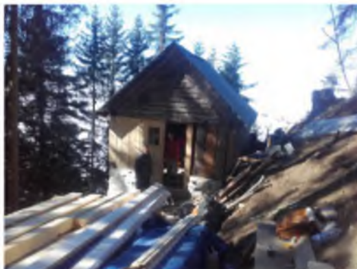
Refuge des Fourmis en travaux
