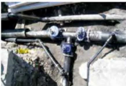
Veytaux – Avenue de Chillon – Pose d'une nouvelle conduite PE 200 mm
