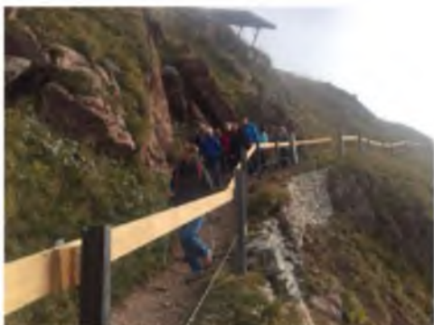
Barrières et mur en pierre rénovés
