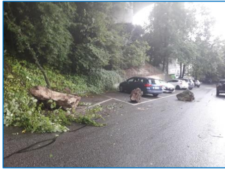
Stabilisation d'une tufière sous le viaduc
