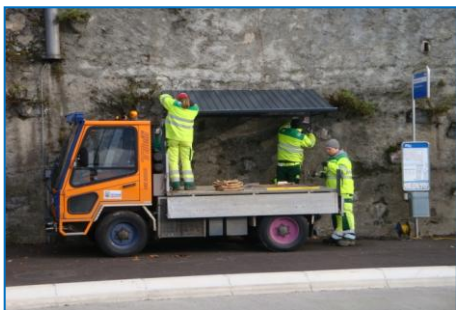
Nouvel abri bus « Veytaux Gare » amont
