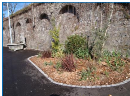
Nouveau massif vers l'arrêt bus « Veytaux Gare » amont, en remplacement de l'ancien arrêt
